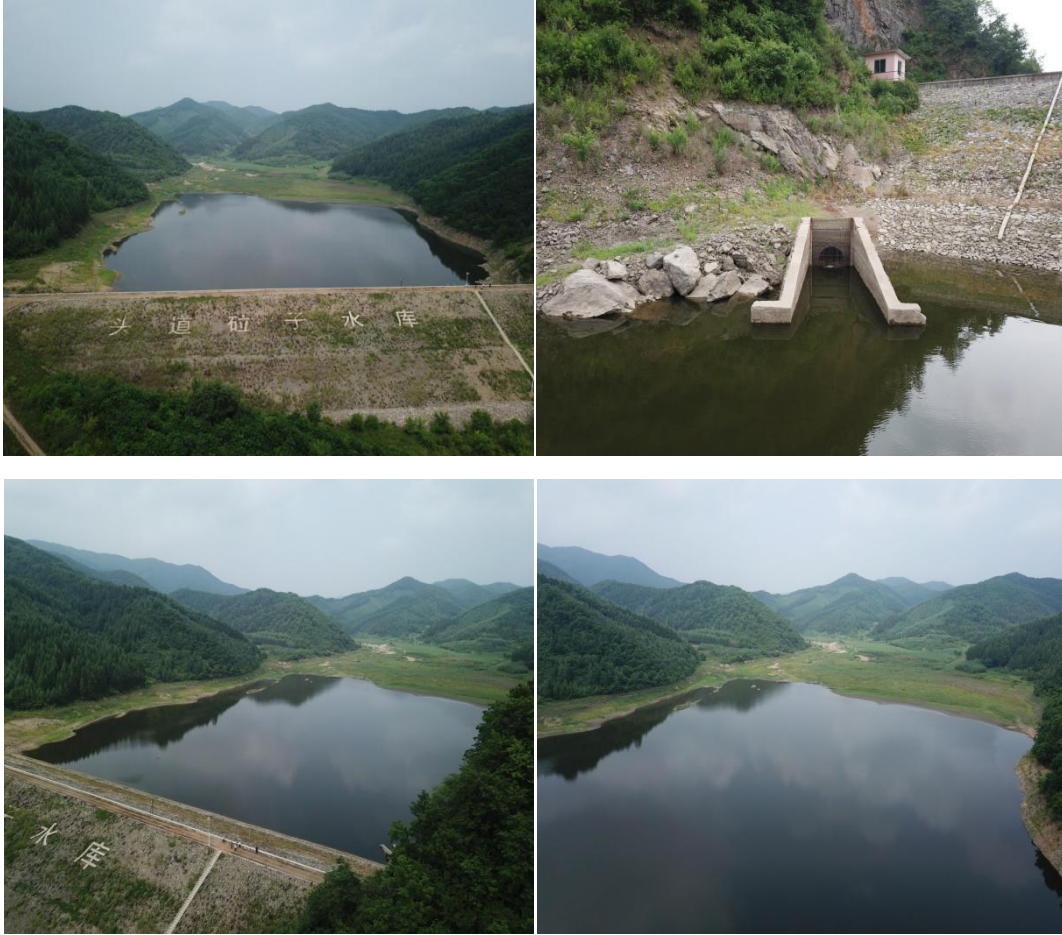
头道砬子水库饮用水水源水库大坝及溢洪道位置
